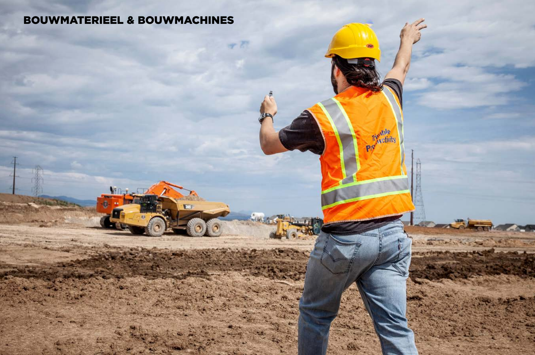
Met Trimble WorksManager verschuift die werkwijze van lokaal naar centraal.
