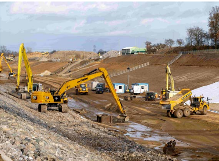
Nagenoeg alle machines zijn uitgerust met Trimble-machinebesturing, van graafmachine tot bulldozer. (Beeld: Paul van Baardwijk)
