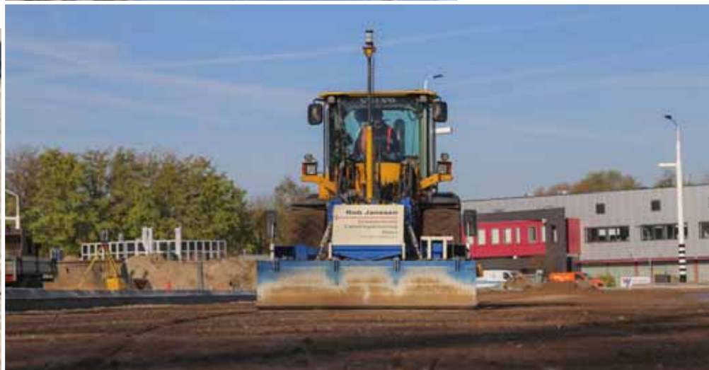
Het resultaat mag er zijn. Hoewel de puinbaan vrij grof is, ligt deze er na het nivelleren op het oog snaarstrak bij. Ook nameten met het veldboek leert dat de afwijking nihil is.
