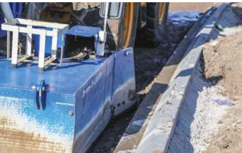
Vanuit de cabine kan machinist Joris de deurtjes openen om zo strak mogelijk langs de rollaag af te werken.
