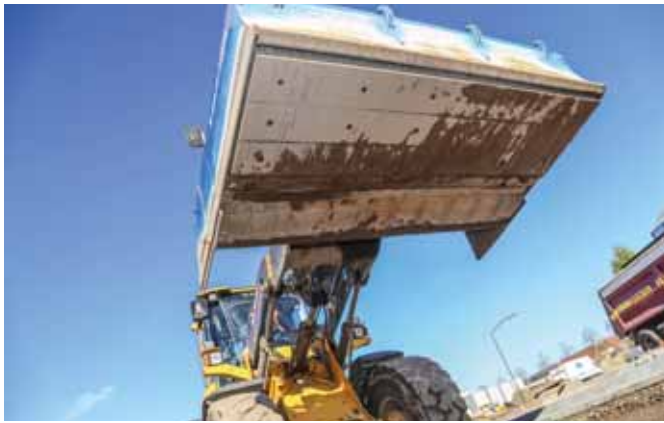
De Mekos-leveler steunt af op de grondslag via drie brede slijtplaten. Deze vormen het vaste punt. Het schuifbord aan wielladerzijde beweegt automatisch omhoog of omlaag op basis van de signalen van het total station. Zo wordt een exacte hoogteregeling verkregen.
