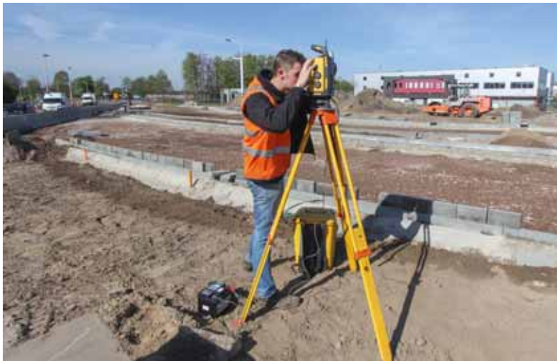
Machinist Joris zet 's ochtends bij aankomst op het werk het Sitech/Trimble total station op. Hij richt het vizier op twee reeds ingemeten punten op een ANWB-paal en een lantaarnpaal. Het station berekent aan de hand van deze twee coördinaten zijn eigen positie.
