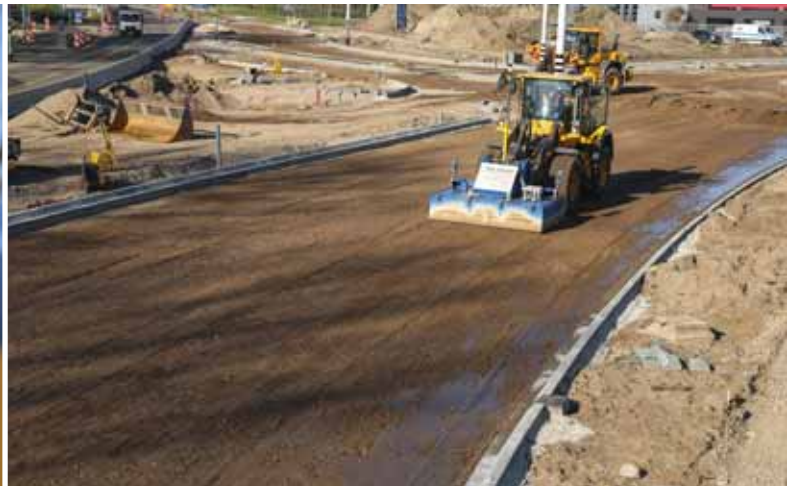
Joris kan al vrij snel aan de slag. Het total station draait actief met de leveller mee. Joris rijdt net zolang totdat de baan overal op hoogte is. Hier zijn nog meerdere gangen nodig.
