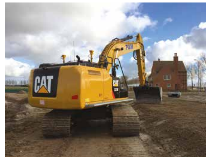
Graafmachine voorzien van de TVG-660, als onderdeel van Trimble FSM.
