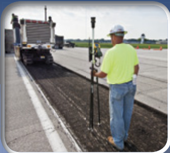
Site Positioning Systemen
