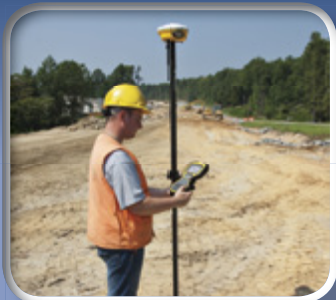
Site Positioning Systemen
