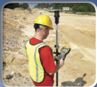
Site Positioning Systemen
